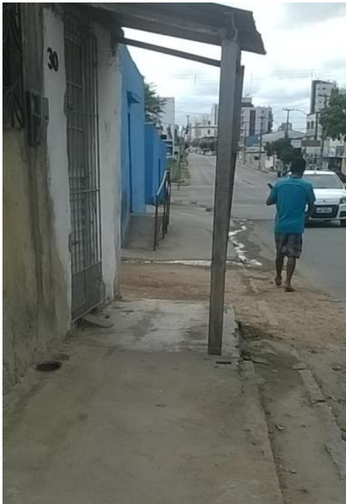
Construção irregular na calçada
