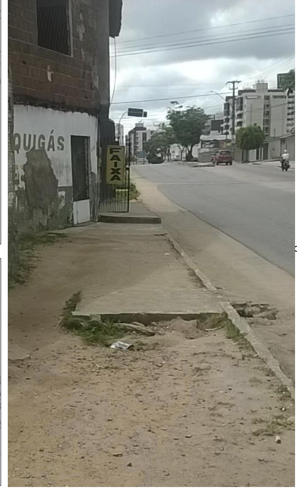
Construção irregular na calçada
