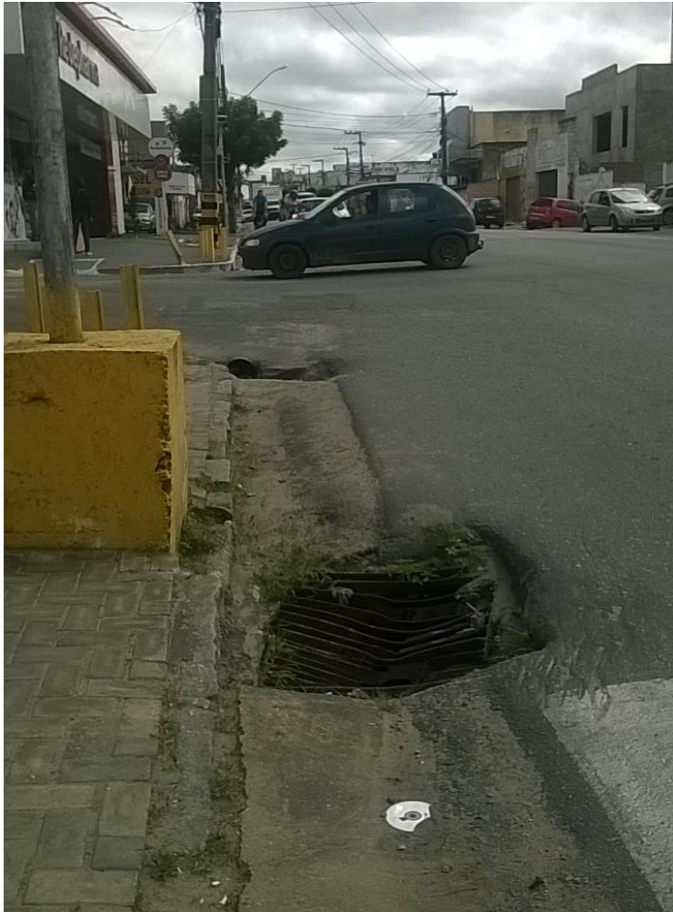
Construção irregular na calçada
